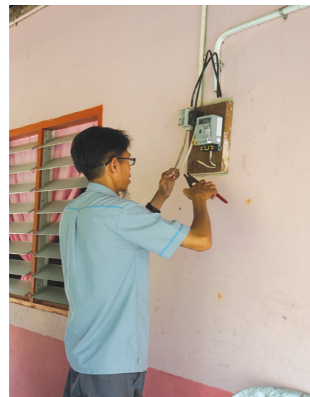
Pemasangan talian servis, 'mains wiring', 'bracket' dan kabinet meter.
