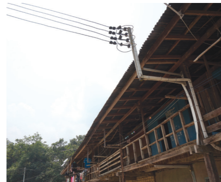
Pemasangan talian servis, 'mains wiring', 'bracket' dan kabinet meter.
