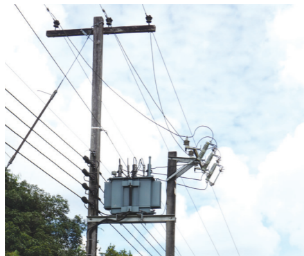
Pemasangan stesen pencawang/ alatubah dan talian elektrik.
